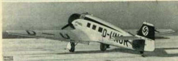
Abb. 7 bis 9. Schnellverkehrsflugzeug „Junkers Ju 160“. Baujahr 1934. Sechs Fluggäste. Reisegeschwindigkeit 320 km/h.
